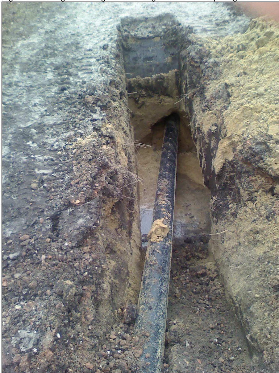
Figuur 3: Drainagebuis aangebracht met gestuurd boren op Zorgvlied
